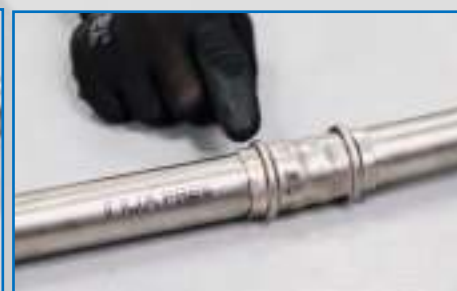
Assemblaggio attraverso pressatura
