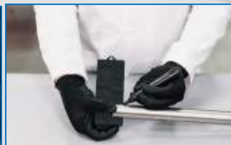
Marcatura della profondità d'innesto
